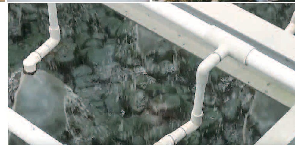
天城抗火石高速散水ろ床法
