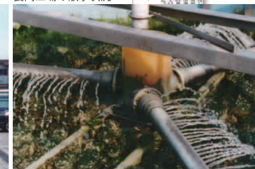
食肉工場の散水状況
