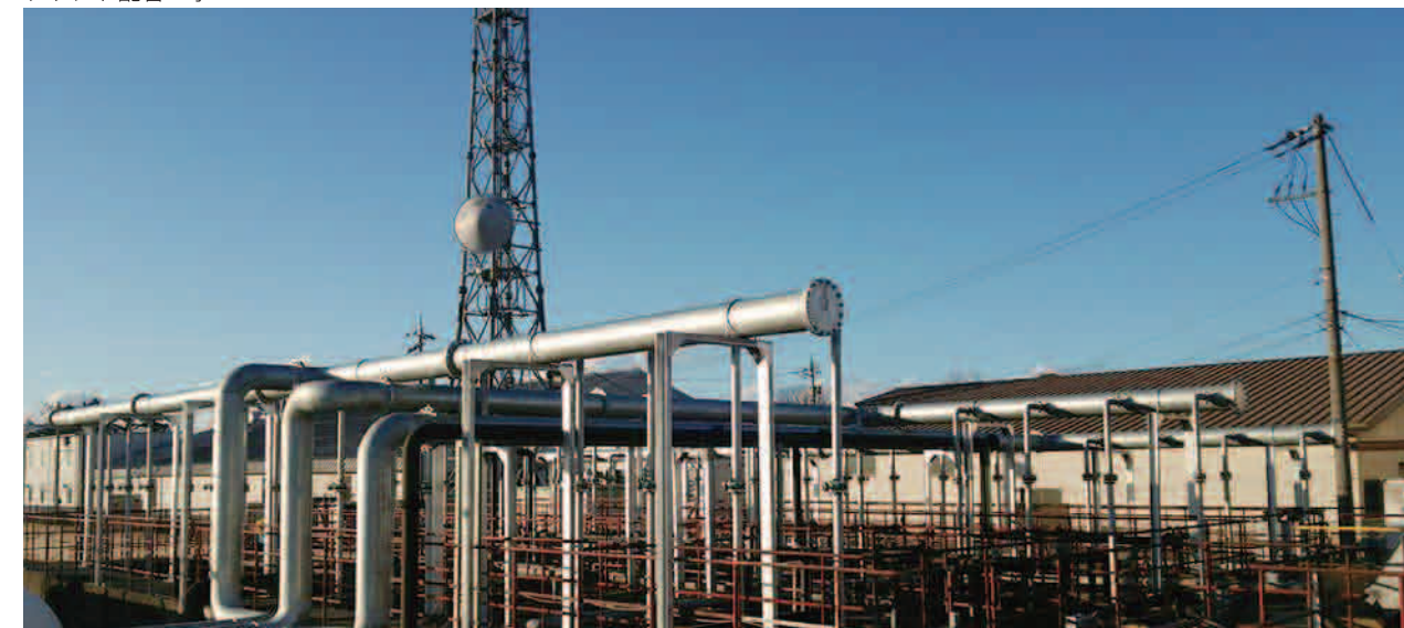
プラント配管工事
