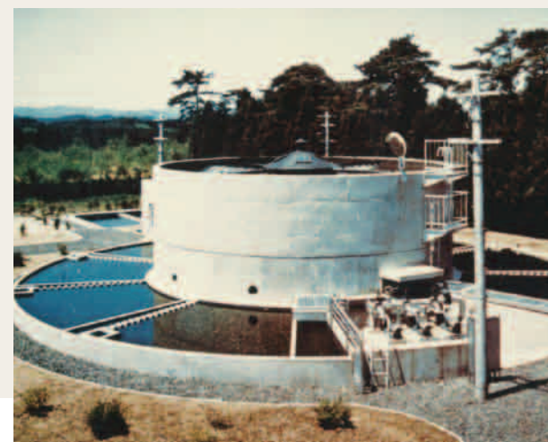
排水処理プラント初導入
